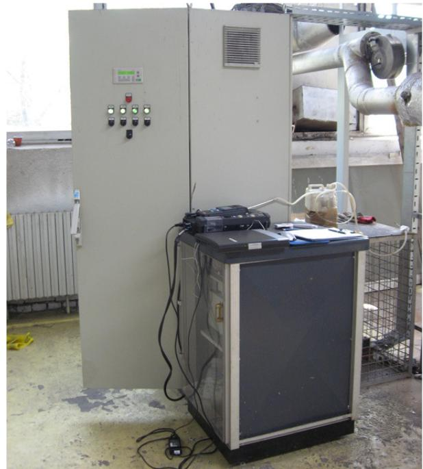
Slika 6.38. Kontrolni ormar sa Siemens Simatic PLC uređajima i TESTO analizator dimnih plinova
