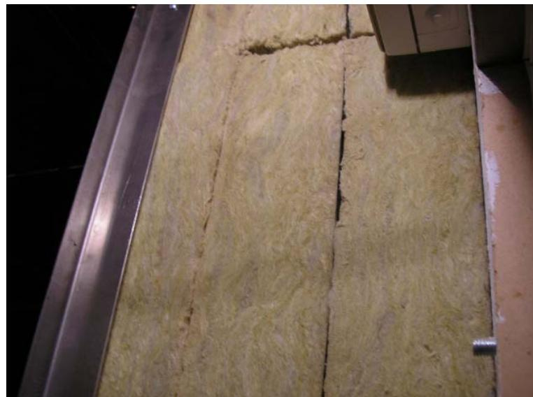
Slika 4.4 Slojevi kamene vune u gluhoj komori
